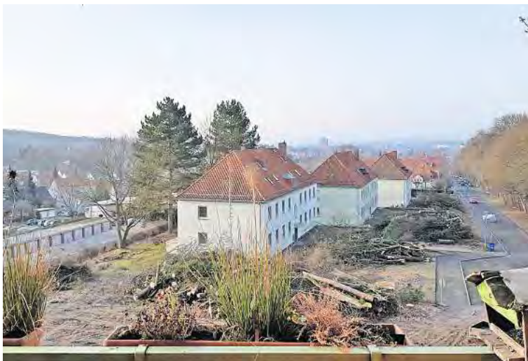
Die Bürgerinitiative Göttingen "Rettet den Spielplatz" hat die Baumfällarbeiten am Nikolausberger Weg für das geplante Neubaugebiet dokumentiert.
